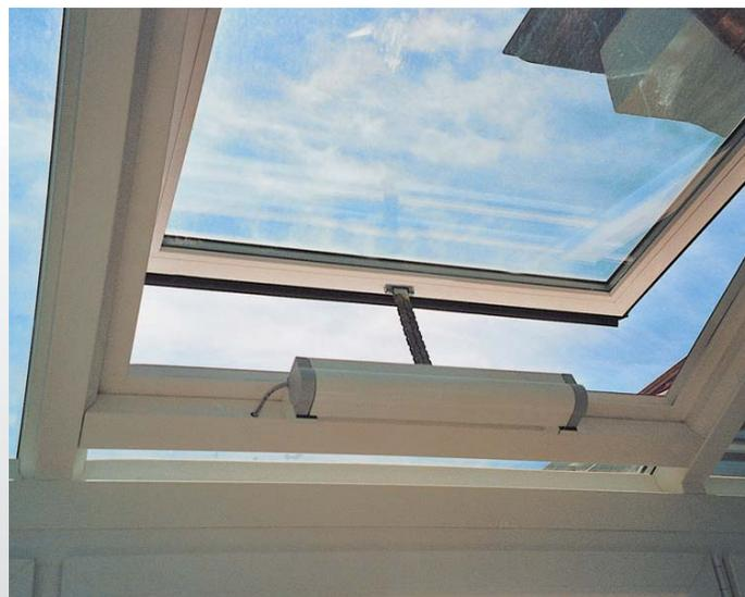
apertura del tetto con motore
