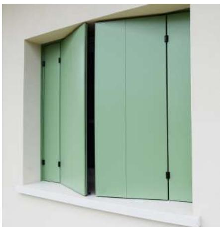
Esempio di foro con ante oltre i 300 mm (1 fuga centrale)
